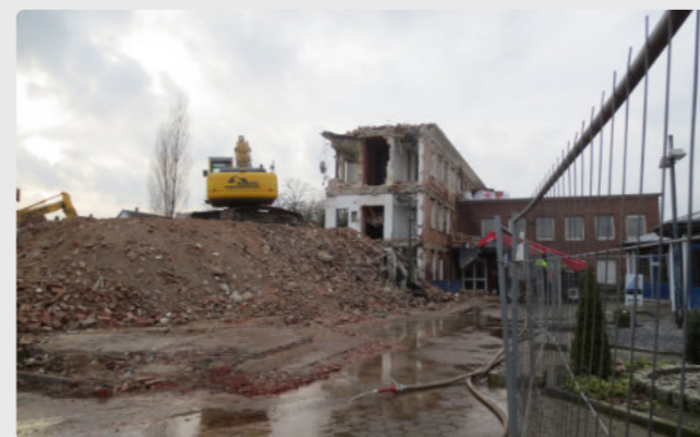
Abbruch des Verwaltungsgebäudes 2016
