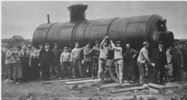
1908 - Zahlreiche Arbeiter vor dem Dampfkessel
