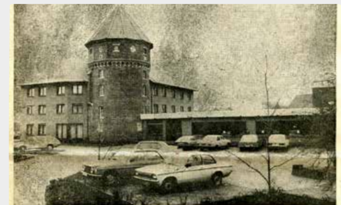
Angelehnt an den alten Burgturm von Oeding zieht das neue „Burghotel“ Pass des Interesse an sich. Das Haus ist umgeben von freundlichen Anlagen. Im Flachbau ist das Restaurant mit Saal und Kegelbahnen untergebracht.
