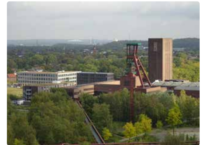
Der Blick vom Turm der Kohlenwäsche
