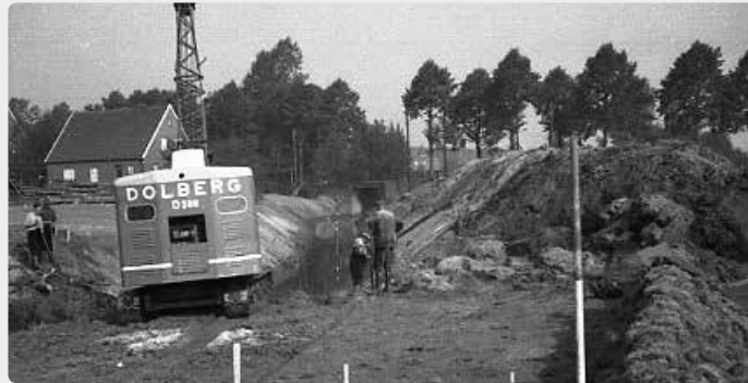
1960 - Arbeiten an der Schlingeregulierung
