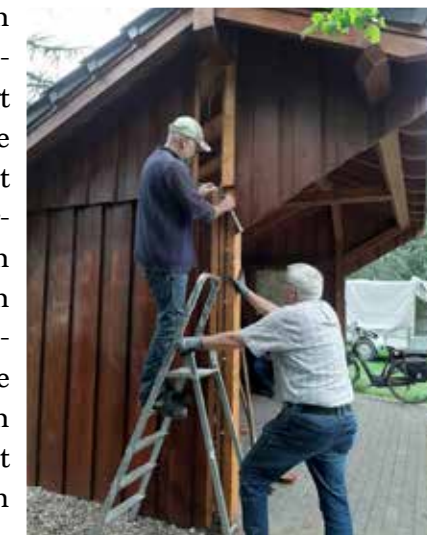
Arbeiten an der Installation
