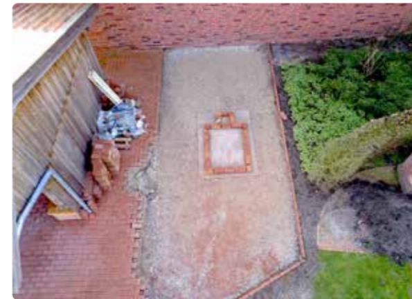
Die Fläche mit Fundament des Backofens März 2019
