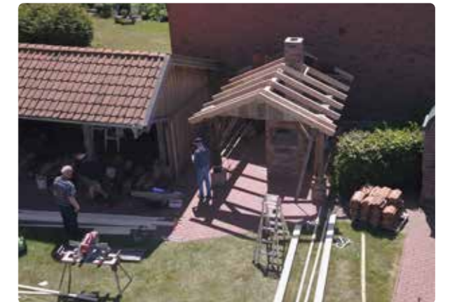
Der Holzbackofen bekommt ein Dach - Mai 2020
