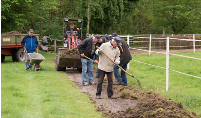
Sanierung des Radweges am Wäpelsgraben
