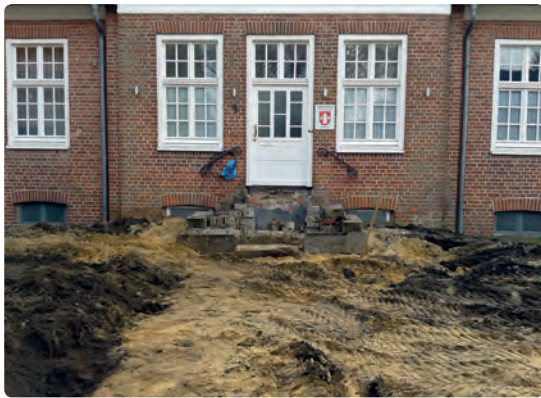
Abbruch des alten Eingangs
