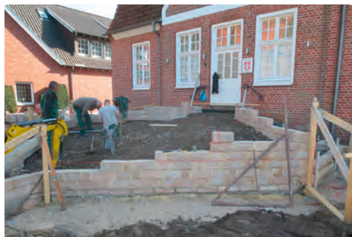
Aufbau des neuen Eingangsbereichs
