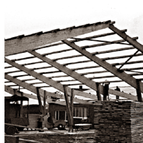
Noch eigenhändig verleimt: die Dachkonstruktion der ersten Werkshalle in Südlohn Anfang der 60er Jahre.
