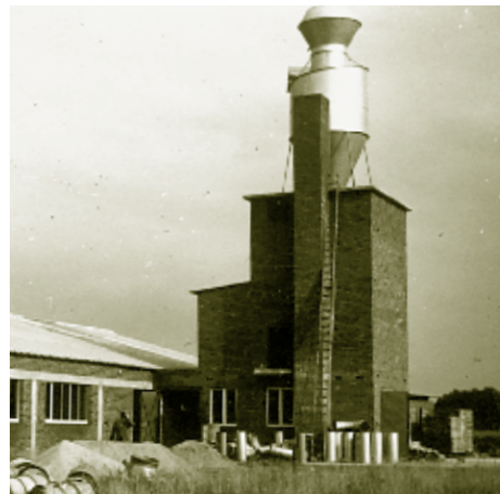
Werksgebäude Anfang der 60er Jahre.
