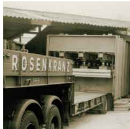
1970: Anlieferung der ersten Durchlaufpresse der Firma Friz für die erste Paneeelfertigung.
