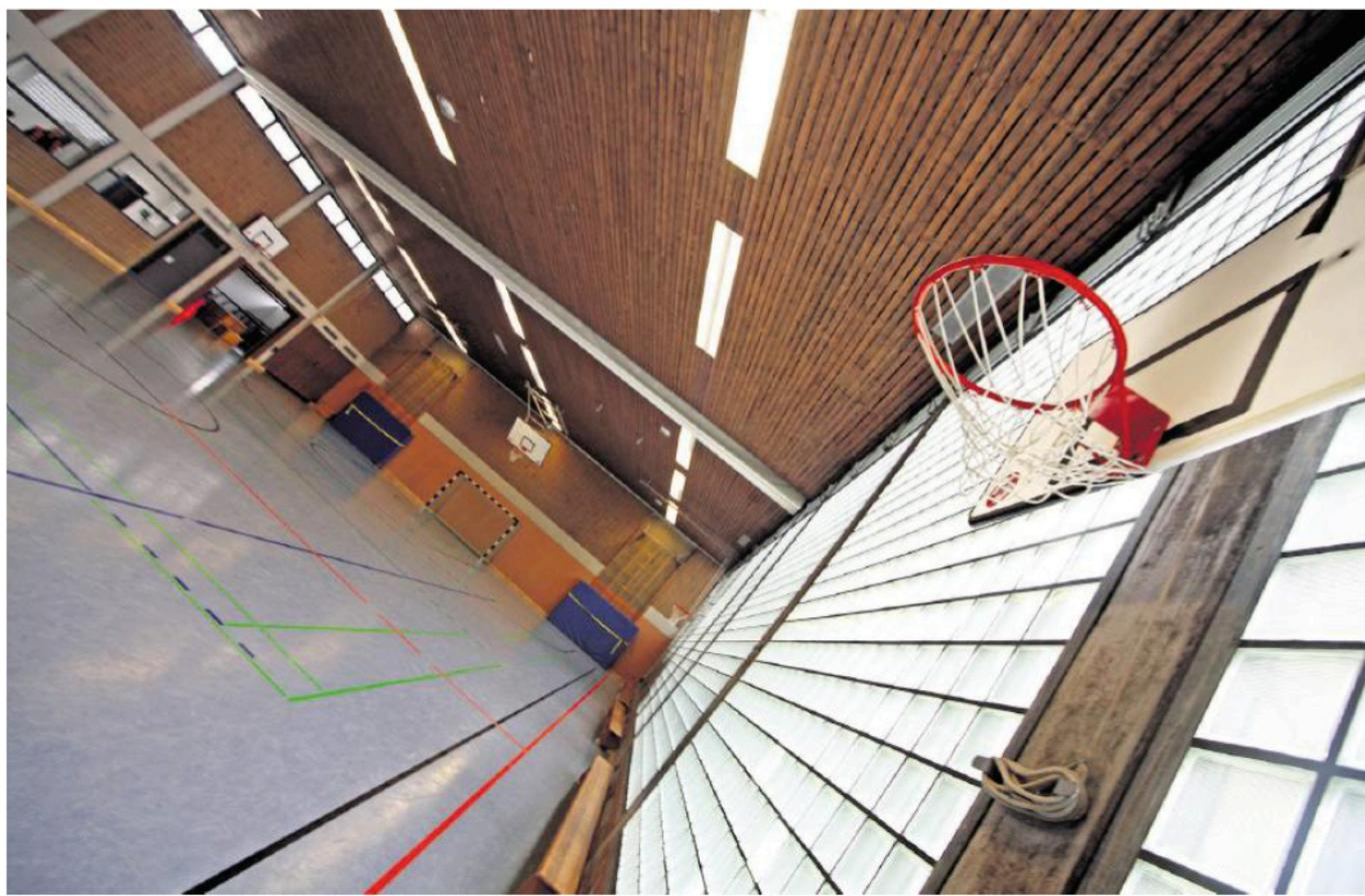
Darüber herrscht Einigkeit: Die Turnhalle an der Roncalli-Schule muss energetisch saniert werden. 44 Jahre alt ist das Gebäude, besonders im Dachbereich und an der Glasbaustein-Fassade ist es mangelhaft gedämmt. MLZ-FOTO GEHRING
