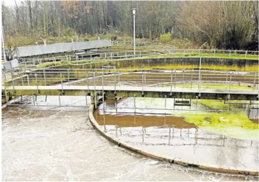
Das Klärwerk in der Bauerschaft Tünte wird um Kombibecken erweitert.
