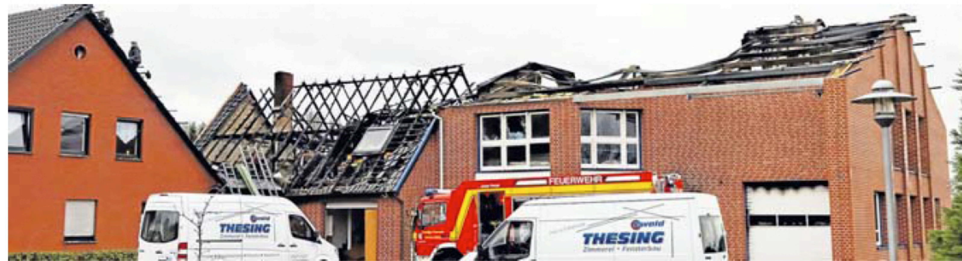
Bei Tageslicht wird das Ausmaß des Brandes deutlich. Polsterei, Lager, Ausstellung sind niedergebrannt. Links wird das Dach des Wohnhauses bereits provisorisch abgedichtet.
