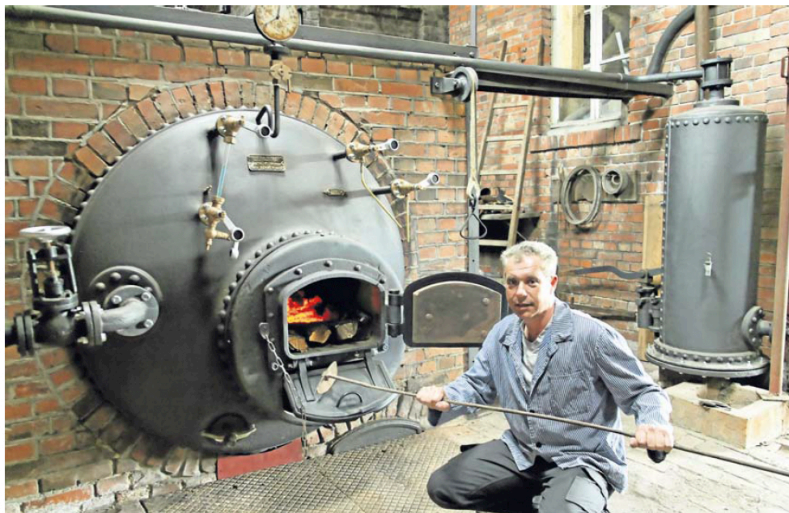
Mit viel Liebe zum Detail hat Dieter Gehling den alten Dampfkessel in der Menke Mühle restauriert, die Dampfmaschine ist in Arbeit.
