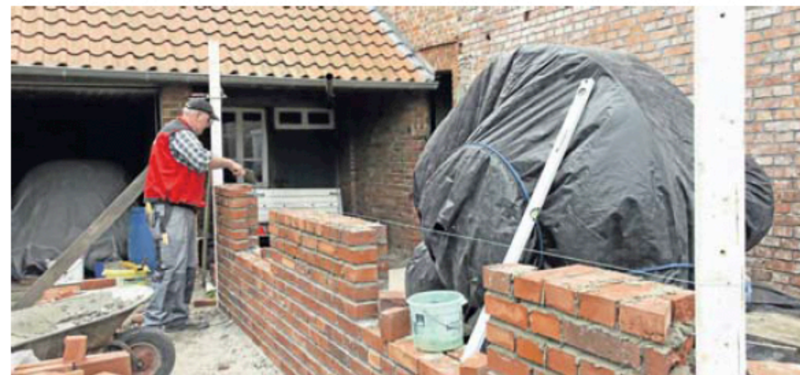
Gut verpackt steht das Gehäuse der Dampfmaschine an der Mühle. Drumherum entsteht zurzeit mit Hilfe des Mühlenvereins ehrenamtlich ein Gebäude dafür.
