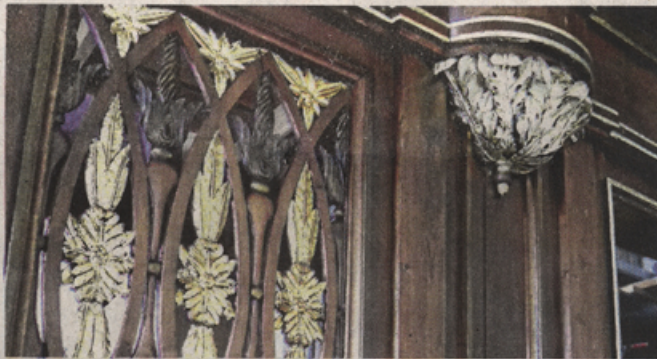
Die Dickschichtlasur auf dem Gehäuse der Orgel wurde entfernt, die Schnitzereien sind wieder sichtbar.
