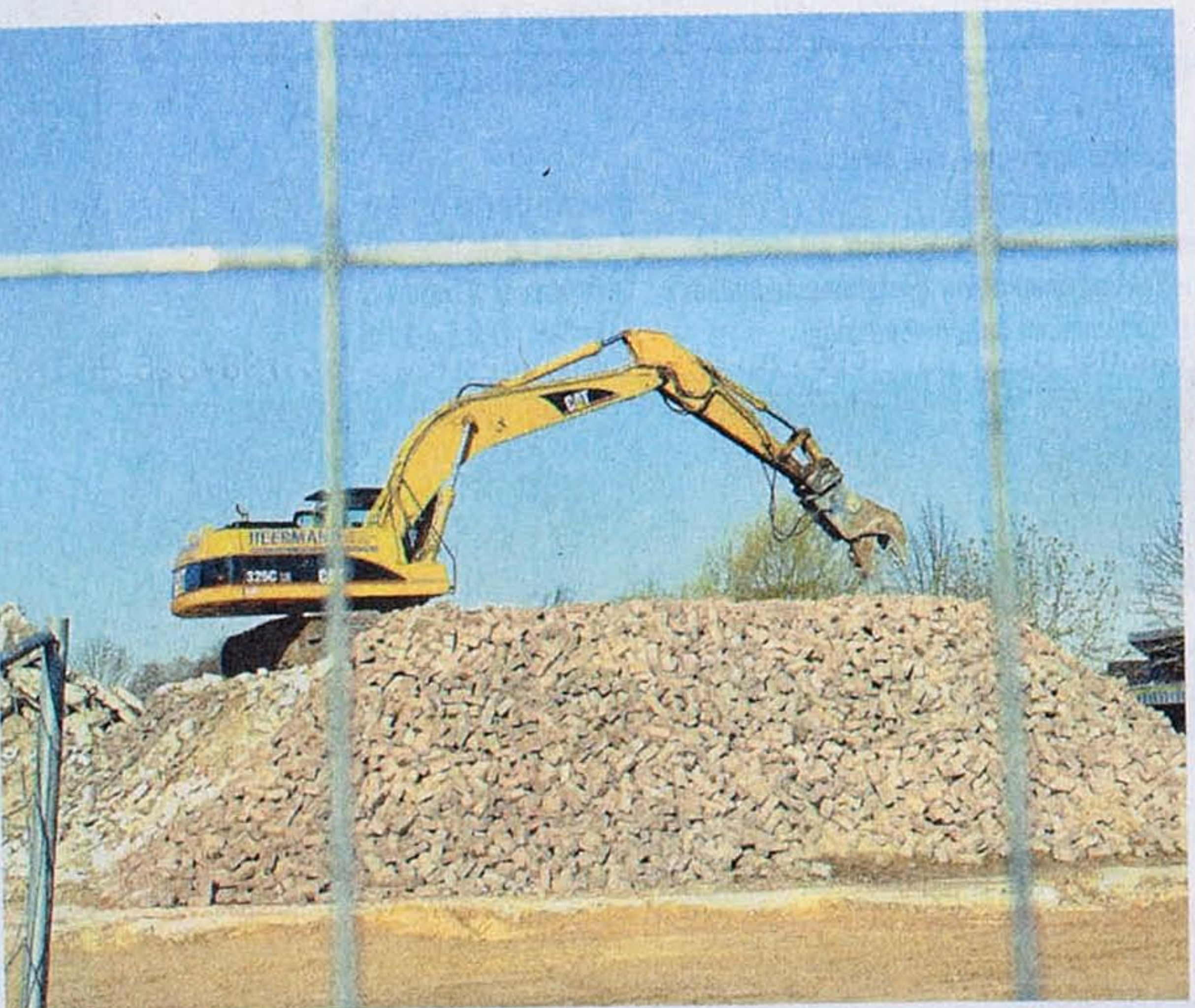
Das sind die Reste des alten Feuerwehrgerätehauses in Oeding. Am Woortweg entsteht ein schicker Neubau. MLZ-Foto Steur
