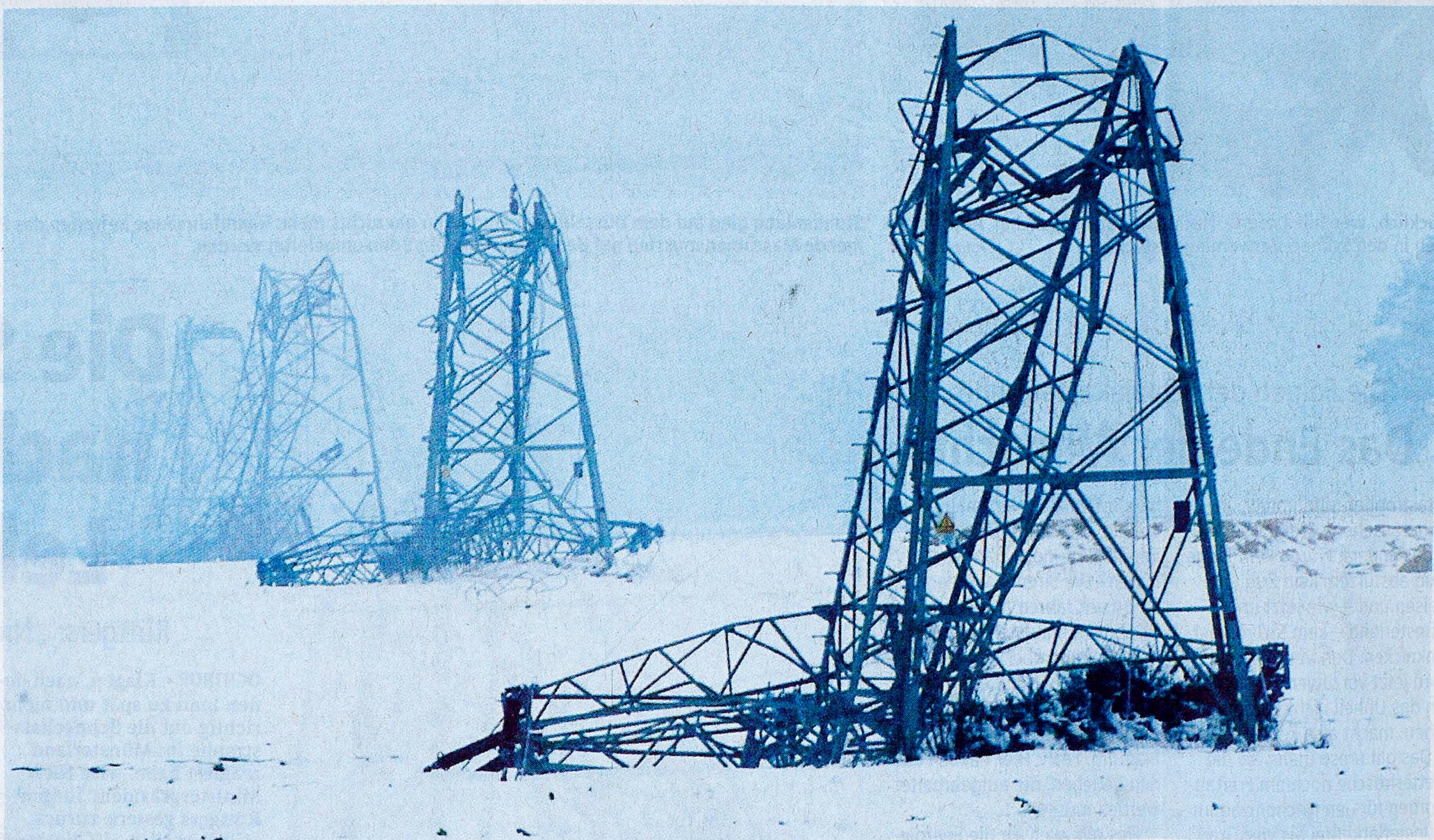
Viele Strommasten im Münsterland hielten dem Gewicht der mit Schnee und Eis dick ummantelten Leitungen nicht stand und knickten – wie hier in der Gemeinde Laer bei Steinfurt – gleich reihenweise ab. Vor allem diese Zwischenfälle stürzten eine ganze Region ins Chaos. Foto: Ueberfeld
