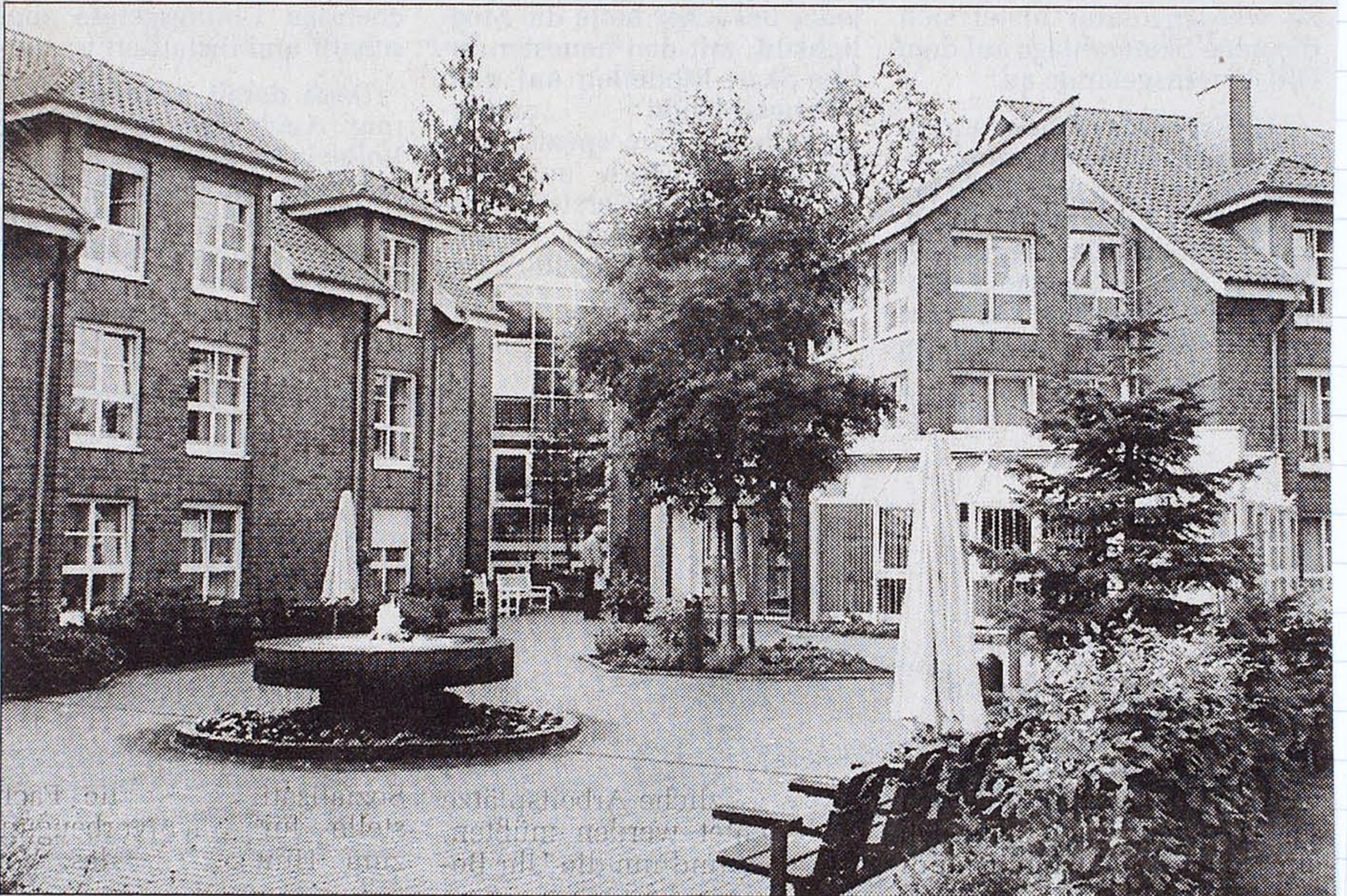
Das neue Henricus Stift im Breul – die Ursprünge des Hauses als Hospital reichen in diesem Jahr 100 Jahre zurück. Foto: Schlusemann
