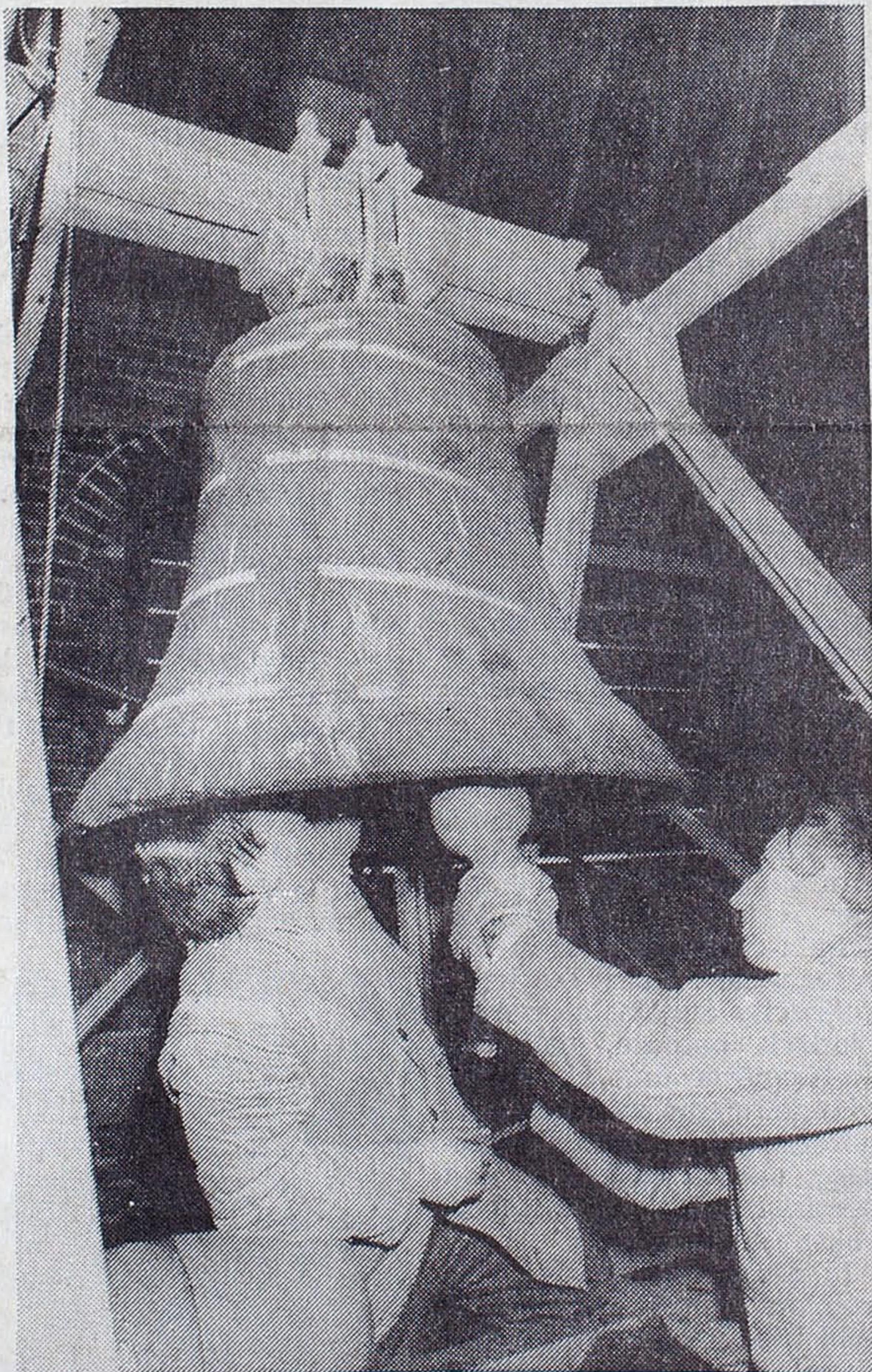
Nachdem alle Klöppel wieder hingen, mußten diese justiert werden. Im Bild die Glockenmonteure bei ihrer Arbeit an der Katharinenglocke, die seit 1390 im Turm der Südlöhner Kirche hängt.
